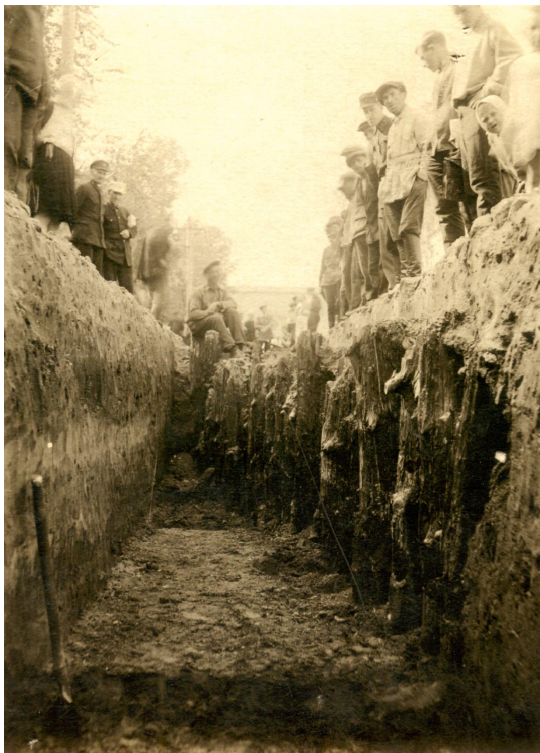
Рис. 10. Фрагменты деревянных укреплений, обнаруженный на ул. Баженова при прокладке коммуникаций в 1935 г.
